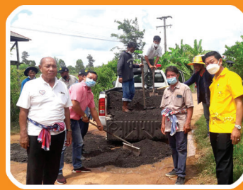
การให้ความช่วยเหลือและ ซ่อมแซมถนนชำรุด ภายในหมู่บ้าน
